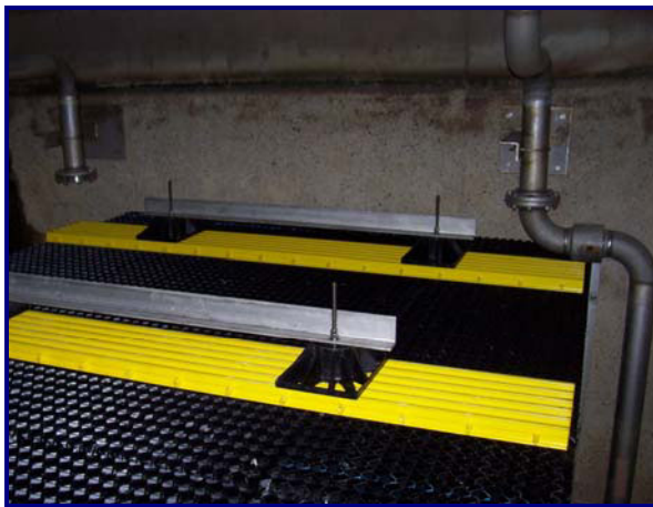
(d) Installing media restraint system
